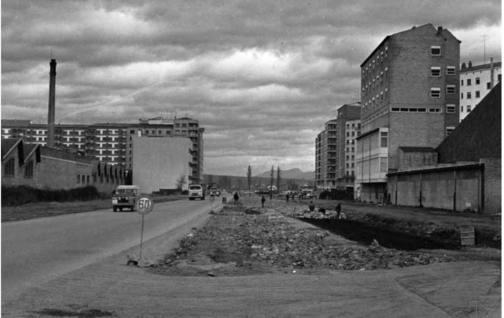
Vista general de la Avenida del Generalísimo. 1967. Foto ARQUÉ. AMVG
