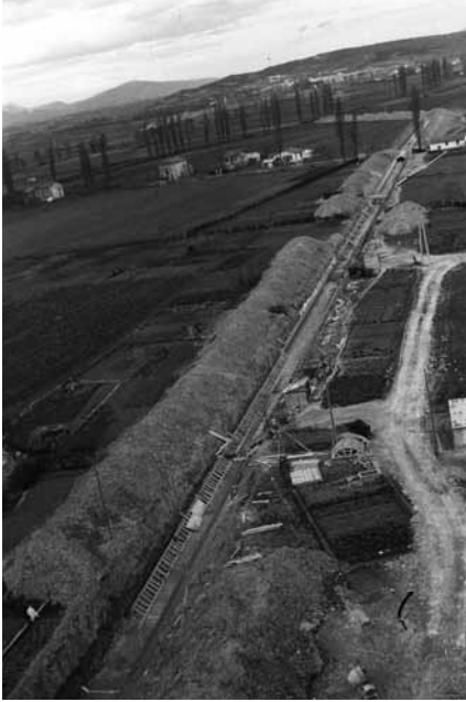
Obras de canalización del río Avendaño. 1961. Foto Santiago Arina y Albizu. AMVG.
