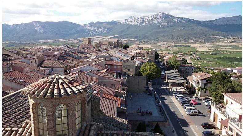
3.1 Vista del lienzo este de muralla desde la torre de San Juan. Puede apreciarse la conservación del paso de ronda. Elaboración propia.
